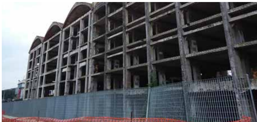
La struttura dismessa di via Tiburtina 1040, sede dell'ex Fabbrica della Penicillina
